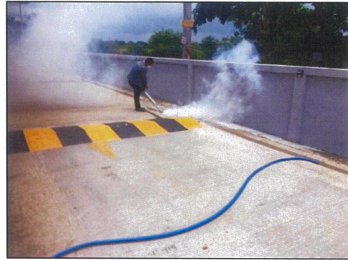
รูปที่ 3-22 ตรวจสอบอุดรอยรั่ว
