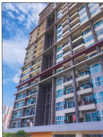
รูปที่ 3-44 ระเบียงห้องพักลักษณะเปิดโล่งได้มีการออกแบบให้มีระแนงช่วยบังแดดให้กับตัวอาคาร โดยไม่บังทิศทางลม และระเบียงส่วนที่ยื่นออกมาสามารถบังแดดให้กับชั้นล่างได้
